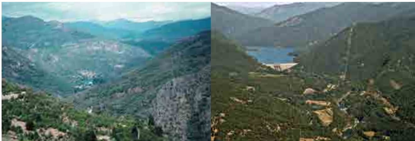
La represa de la central hidroeléctrica Ralco, en el río Biobío, que entró en operación en 2004, es una de las más altas del mundo con 155 metros de altura y 360 de longitud. La central Pangué, de 103 metros de altura y 410 de longitud, construida aguas abajo entró en operación en 1996. Las dos represas inundaron 4.000 hectáreas y degradaron en forma brutal 70 kilómetros del valle del Alto Biobío, asestandole un golpe mortal a una de las cuencas ecológicamente más ricas de Chile, habitada por comunidades indígenas Pehuenche. Fotografía izquierda: Alto Biobío antes de la construcción de represa Ralco. Juan Pablo Orrego. | Fotografía derecha: Alto Biobío intervenido por mega hidroeléctrica de Endesa. Douglas Tompkins.
