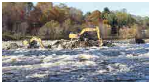
Demolición de represa en el río Penobscot, Maine, Estados Unidos. Fotografía: American Rivers.
